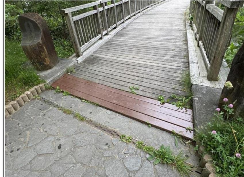
幸運橋の入口の腐食している部分を取外し新しい板部材と交換。
