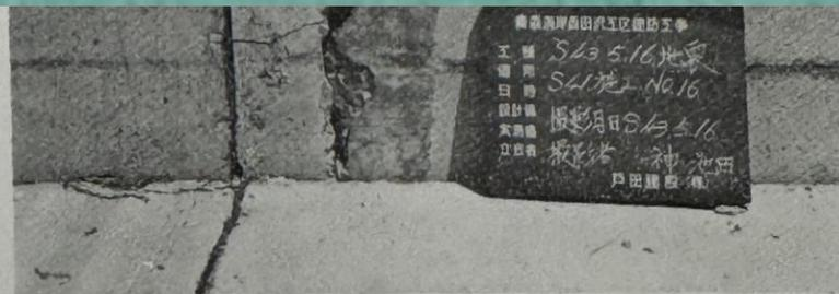
写真1・3・15-5 波返しのジョイント付近のき裂
